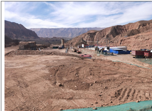
照片 1-1 工业加工场地及道路
